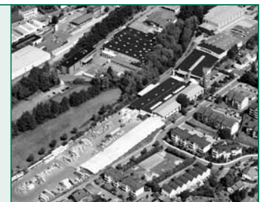
MJ-Gerüst GmbH am Standort Plettenberg (D)
