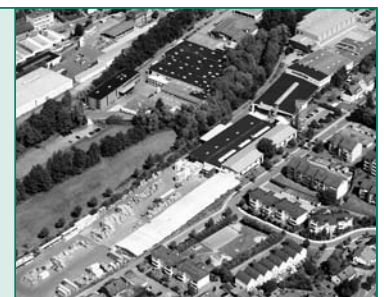
MJ-Gerüst GmbH am Standort Plettenberg (D)
