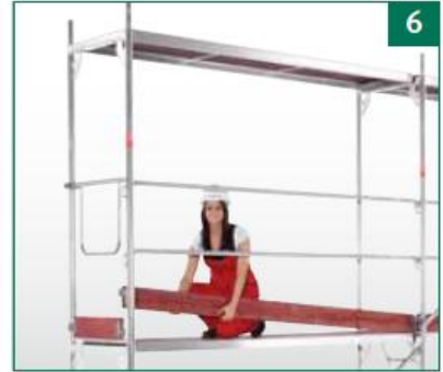
Stellrahmen und Beläge der nächsten Lage montieren, Diagonale, Geländer und Bordbretter einhängen,
